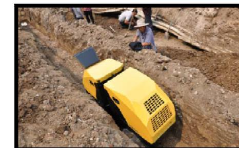
O controle remoto do compactador tem duas classes de forças de vibração: baixa e alta. Elas podem ser intercambiáveis facilmente para atender diferentes condições de construção.
